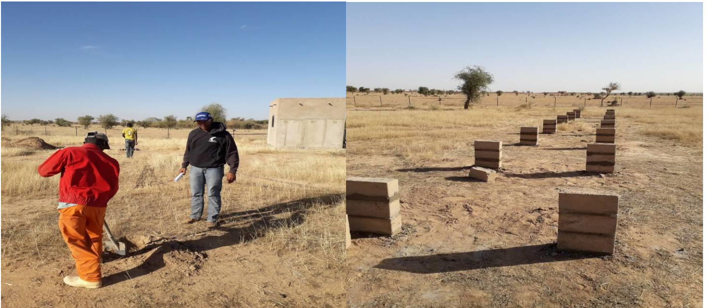
Photo7 : mise en place support séchoir
