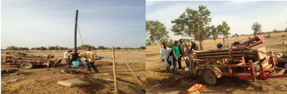
Photo 1, pose des tuyaux. Photo 2 Premier sondage entre l'eau et la surface est 39,4 mètres les 21 mètres est de l'eau.
